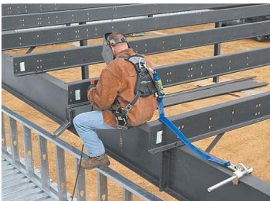
(ก) การเชื่อมงานบนที่สูง (Welding at heights)
